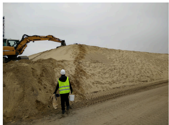
Abbildung 3.1: Vorbelastungsschüttung Baakenhafen Nord
