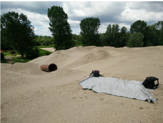
Abbildung 3.3: Spülfeld Moorburg-Ellerholz, oberes Ende (Spülkopf)
