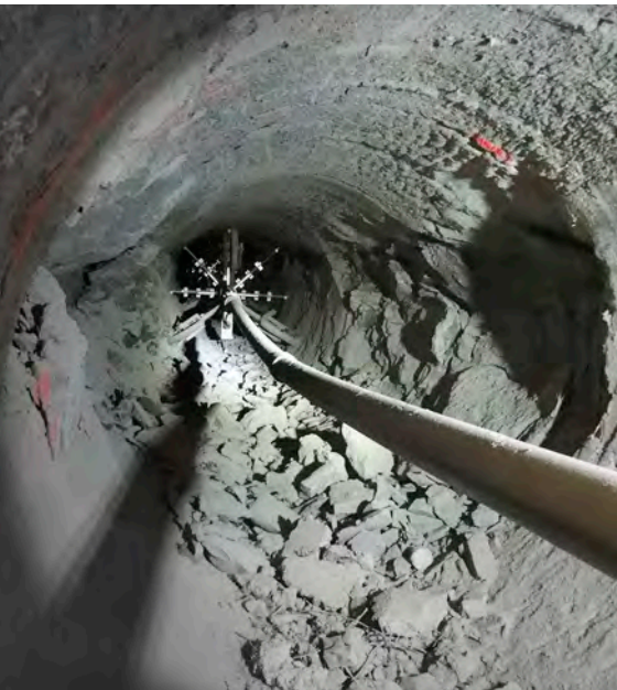
Offene Horizontalbohrung im Tonstein, Untertagelabor Bure
