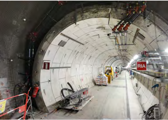
Streckenausbausystem im Untertagelabor Bure
