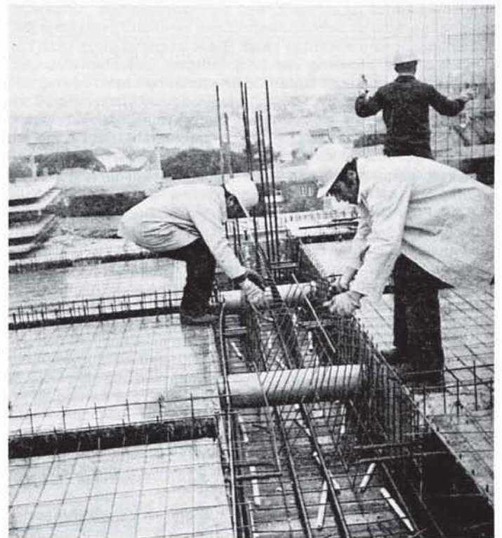
Bild 35: Einbau von Schubzulagen (entnommen aus [43])
