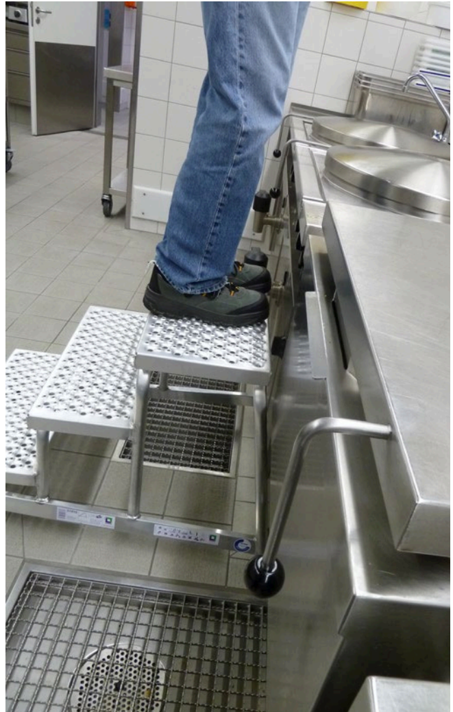
Abb. 18 Reinigung von Ablufthauben unter Verwendung einer standsicheren Aufstiegshilfe mit rutschhemmenden Stufen
