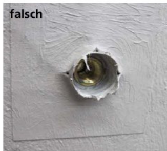
falsch Nach dem Heraus-schrauben des Baustopfens für die folgende Installation hat die Dichtmanschette ihre abdichtende Wirkung völlig verloren.
