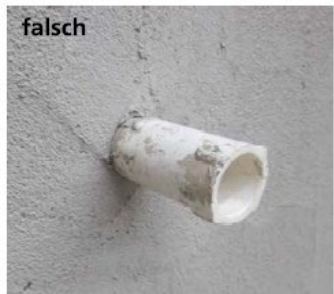
falsch Eingeputzter Baustopfen, an welchem man nicht fachgerecht abdichten kann.
