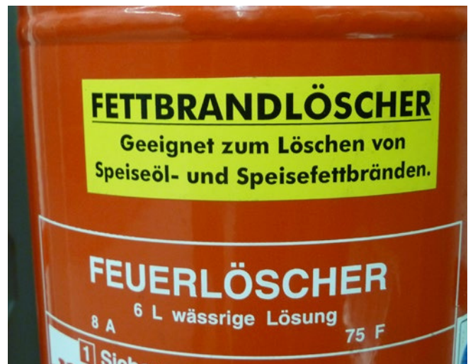
Abb. 12 Kennzeichnung eines für Fettbrände geeigneten Feuerlöschers
