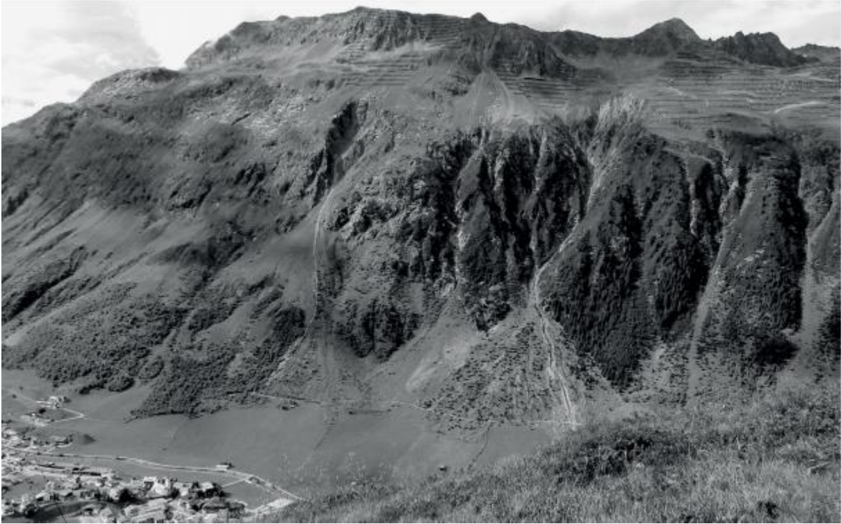
Abbildung 25: Galtür mit Blick auf die Lawinverbauungen am Grieskogel (Titz et al., 2016, p. 54)
