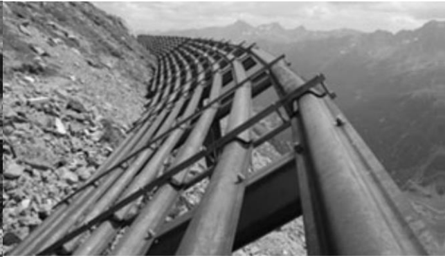
Abbildung 21: Schneebrücke (Schrenner, 2012, p. 17)
