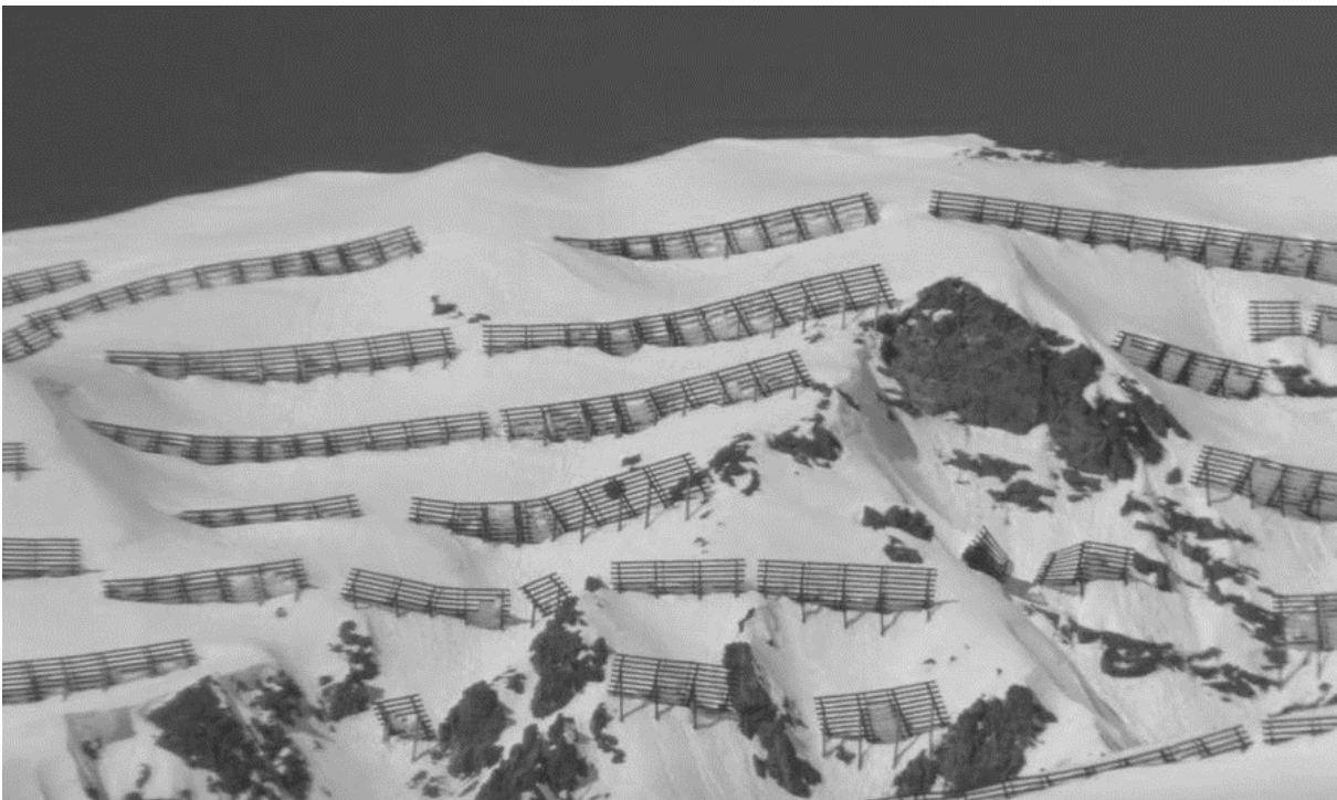
Abbildung 26: Lawinverbauungen in Galtür (Schuchter, 2019)
