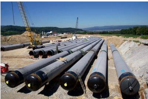
Bild B.3.18: Bau des Erdgas-Röhrenspeichers bei Urdorf, Schweiz (Sternner und Stadler, 2014)
