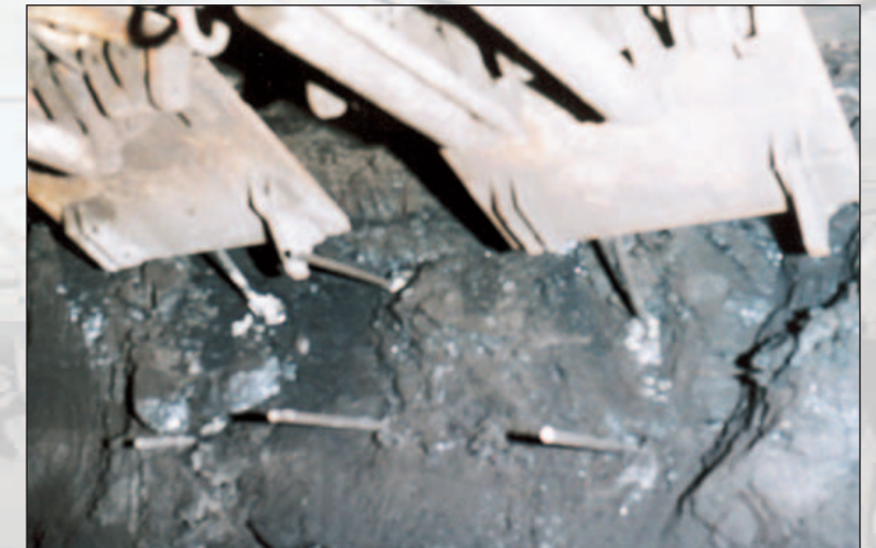
Bild 4: Kohlenstoß mit Glasfaserankern gesichert.
