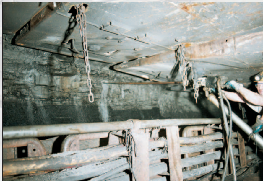
Bild 7: Bohrarbeit aus dem Fahrfeld.
