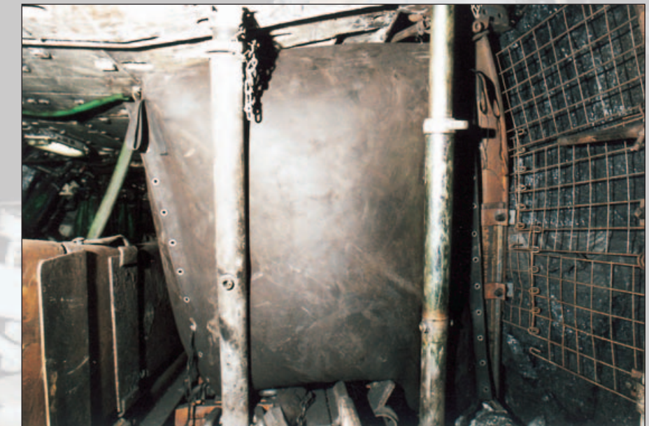
Bild 8: Einsatz eines Luftkissens im Streb.
