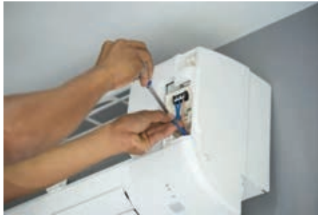
Fig. 4.5.3.5 : Remove the front cabinet
