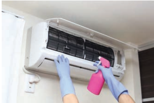
Fig. 4.5.3.2 : Cleaning the dust
