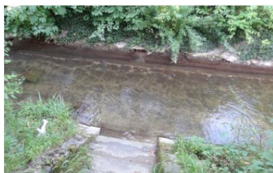
Möhlinbach in Möhlin mit Ufer- und Sohlverbau
