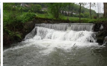
Wanderhindernis in der Surb in Unterendingen
