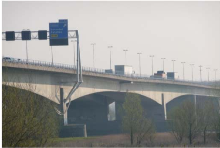
Betonbrücke, Deventer, Niederlande
