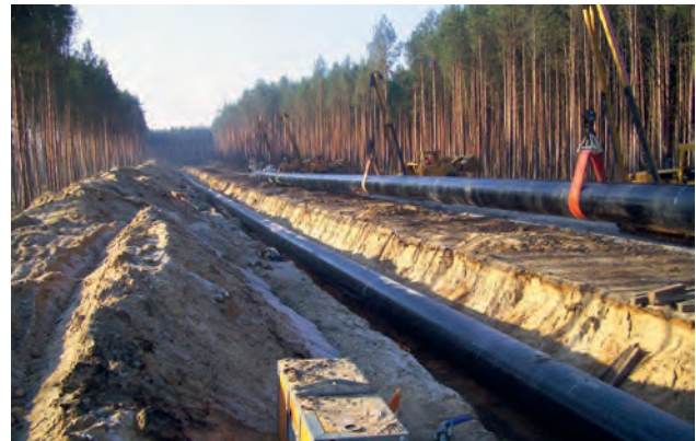
Abb. 8 Bau der OPAL-Trasse 2010
