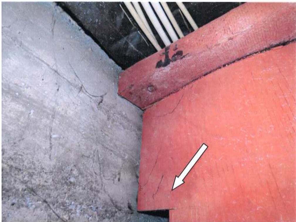
Foto 32: Holz-Wellstegträger: ausgeschnittener Wellsteg im Auflagerbereich
