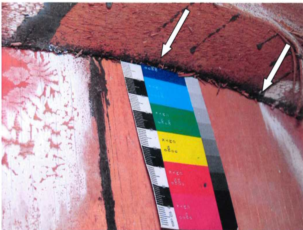
Foto 26: Holz-Wellstegträger: Detailaufnahme offene Klebe-Längsfuge nach Foto 18 mit Spalttiefe ca. 10 mm
