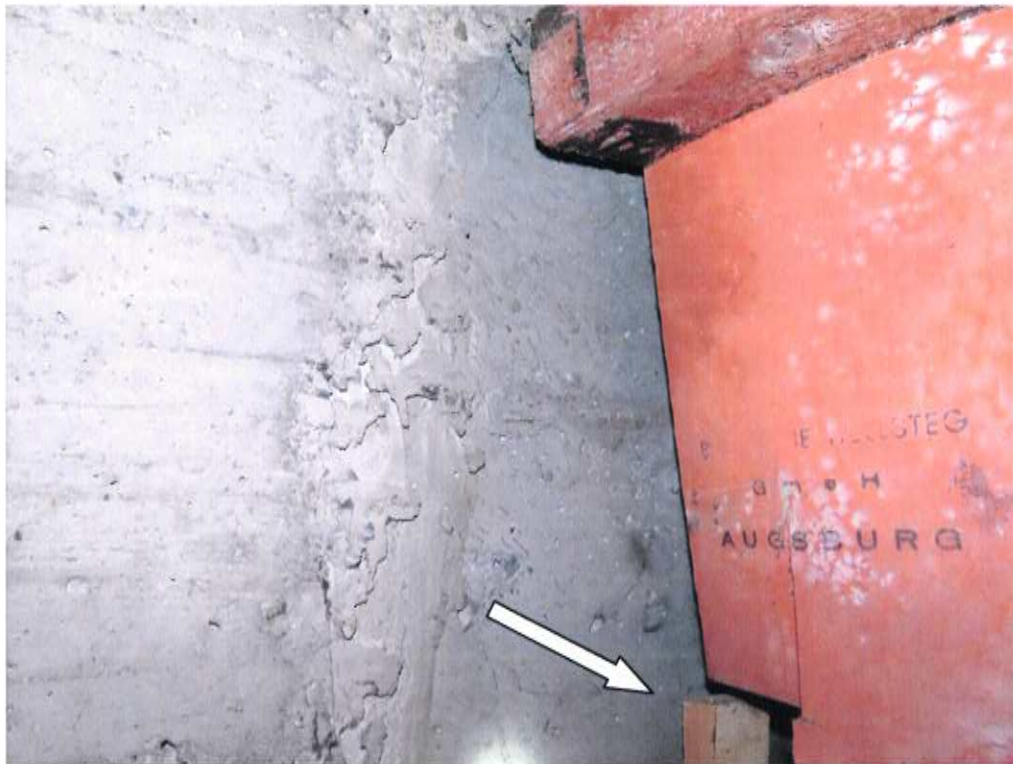
Foto 35: Holz-Wellstegträger: ausgeschnittener Wellsteg im Auflagerbereich
