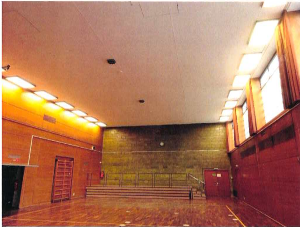
Foto 1: Übersicht Mehrzweckhalle, Blick Richtung Süd (vor Rückbau Leuchten)
