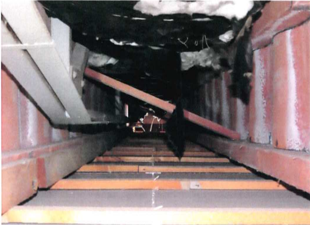
Foto 17: Holz-Wellstegträger: unwirksame / wegen Stahlfachwerk fehlende Auskreuzung zwischen Wellstegträgern (exemplarisch); exzentrische Aufhängung der abgehängten Decke über je ein seitlich angenageltes Brett (am linken Wellstegträger) erkennbar
