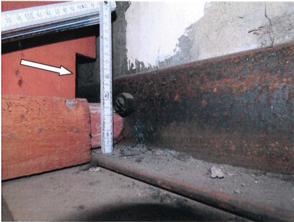
Foto 33: Holz-Wellstegträger: ausgeschnittener Wellsteg im Auflagerbereich
