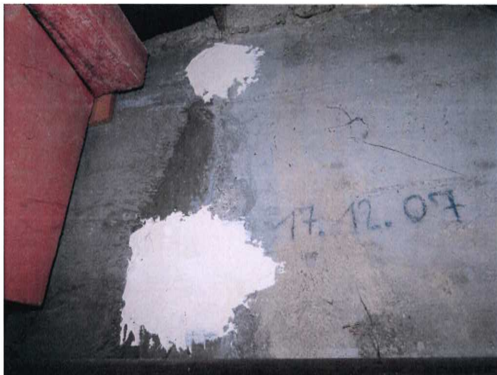
Foto 4: Stahltragwerk: Lagerbereich mit Gipsmarken (ungerissen)
