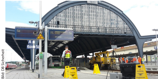
Abb. 9: Inspektion von Bahnhöfen
