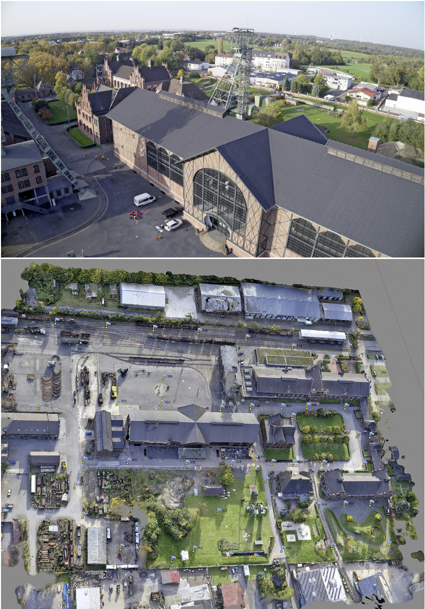
Abb. 4: Zeche Zollern – Blick auf das Gesamtensemble mit dem Maschinenhaus im Vordergrund (oben). 3D-Modell mit signalisierten Bodenpasspunkten (GCP), UAV-Befliegung vom 16.10.2017 (unten)
