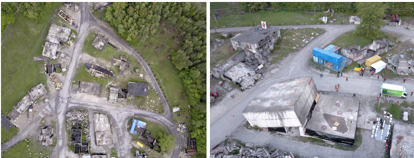
Abb. 6: Übungsgebiet mit zerstörten Gebäuden
