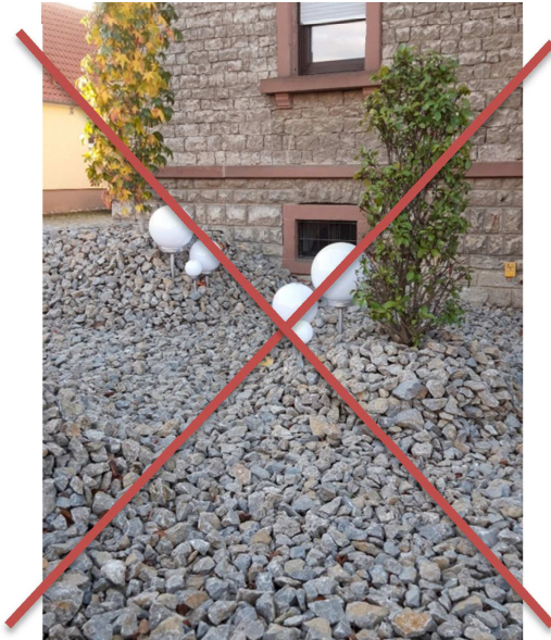
Unzulässigkeit von Schotterschüttungen u.ä
