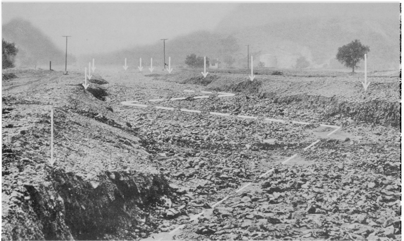
Fig. 23 Trockenes Gerinne eines Wildbaches in kanalisierter «Flachstrecke» mit ungeschützten Ufern, kurz nach einem rasch durchlaufenen und sehr schnell abgeklungenen Hochwasser. Man beachte die rhythmische Anordnung der Uferangriffsstellen (Pfeile) und entsprechende Spuren auf der Gerinnesohle (im Vordergrund befindet sich quer dazu eine Buldozerspur). Los Angeles County, Feb. 1962 ( J_s = einige Prozente Wassertiefe \leq 0,5 m).
