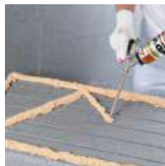
Dämmstoffplatte einschäumen
