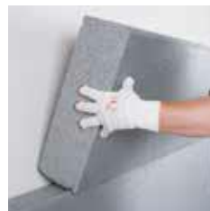
Dämmstoffplatte ankleben
