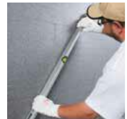
Dämmplatten nivellieren
