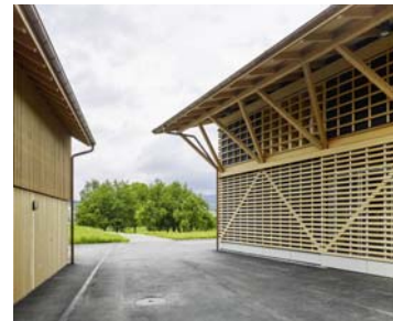
Bild: Graber Pulver, Zürich / Fotograf: Georg Aerni, Zürich
