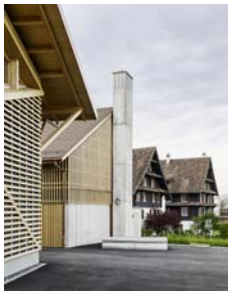
Bild: Graber Pulver, Zürich / Fotograf: Georg Aerni, Zürich
