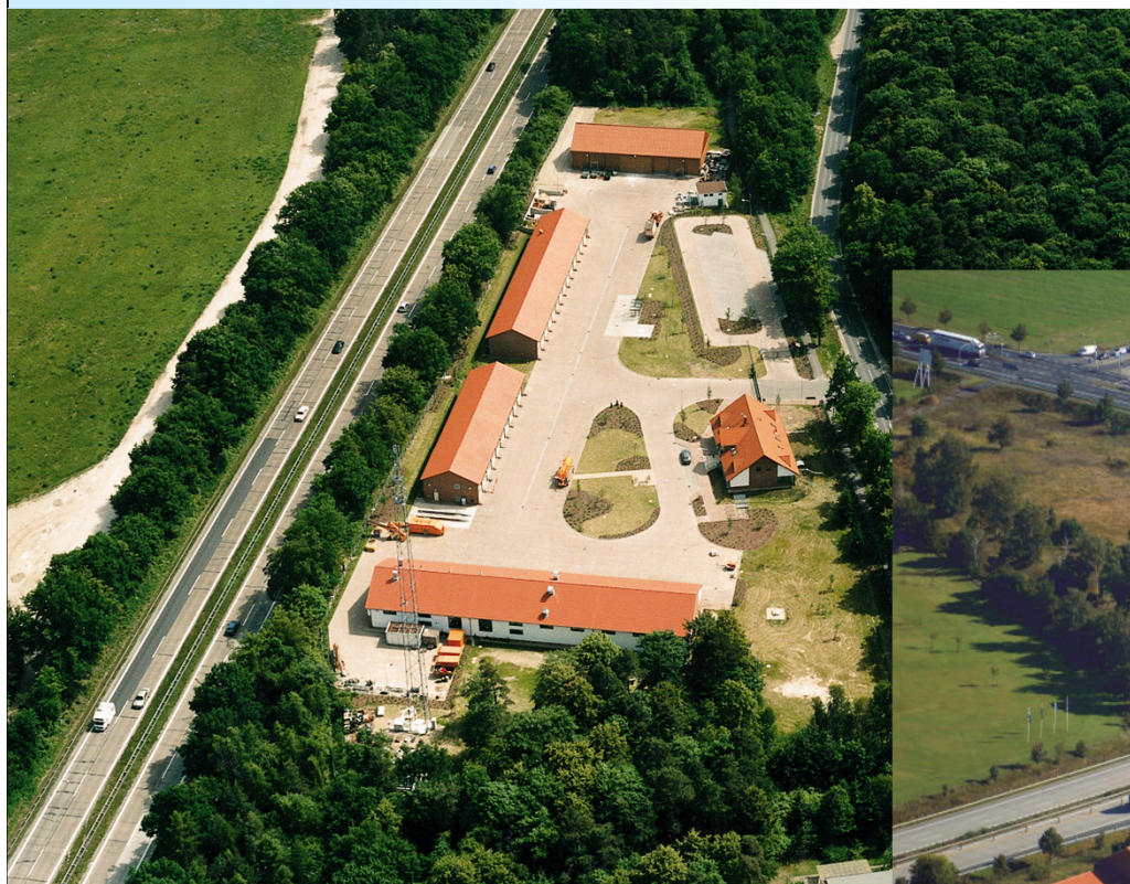
Nebenanlage Autobahnmeisterei Bernau
