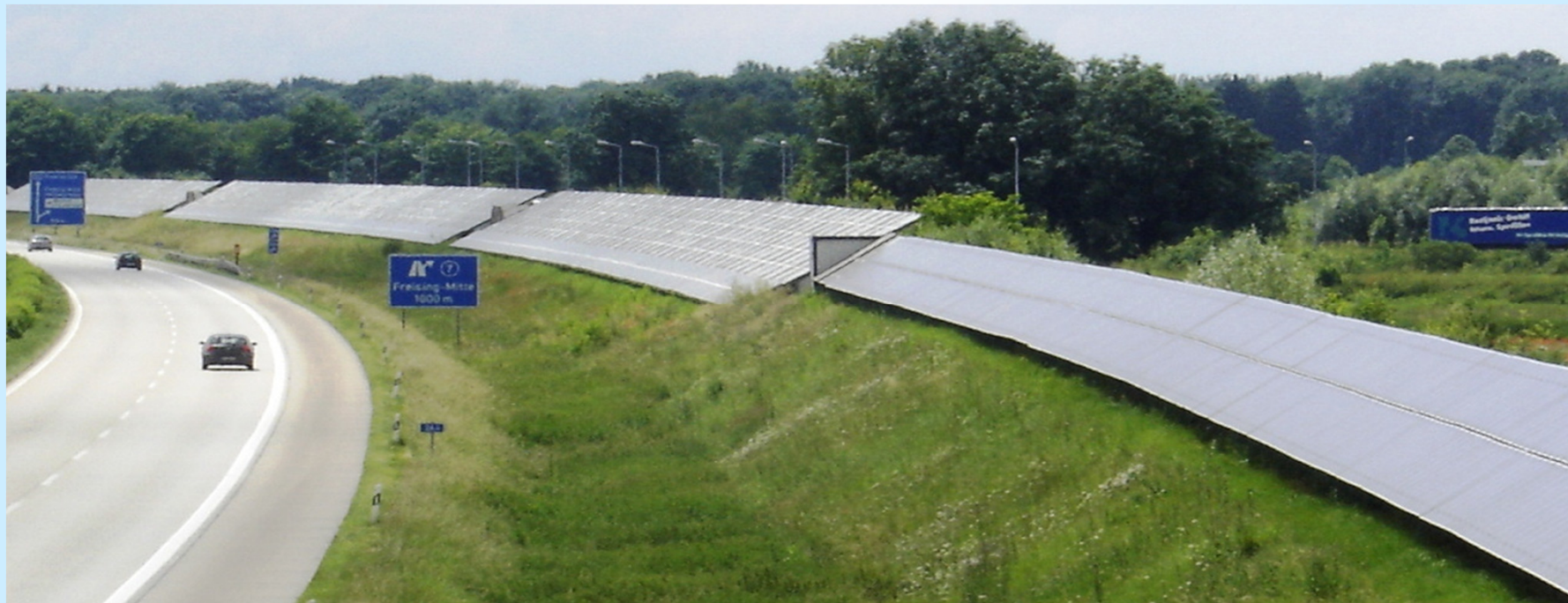
Beispiel für einen Lärmschutzwall mit Photovoltaik-Anlage - hier Photovoltaik-Lärmschutzwall An der A 96 bei Freising (Quelle: Mörgenthaler Ingenieure Planungsgesellschaft mbH)
