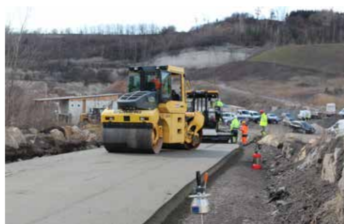
Nachverdichtung des Betons mit Glattmantelwalze
