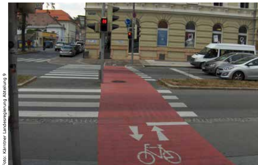
Foto: Kärntner Landesregierung, Abteilung 9 Maximilianstr. – vorgezogene Haltelinie: Markierungsarbeiten erhöhen die Sichtbarkeit und somit die Verkehrssicherheit von Radfahrern
