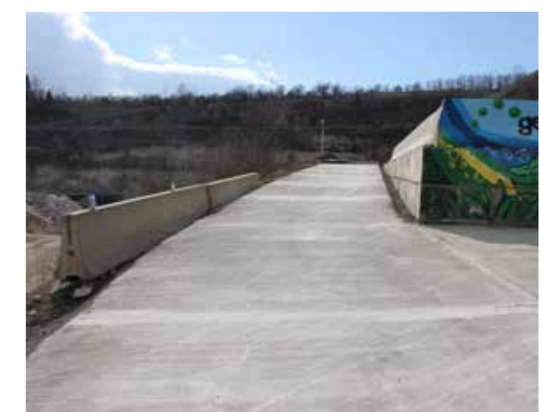
Die fertiggestellte Werkszufahrt
