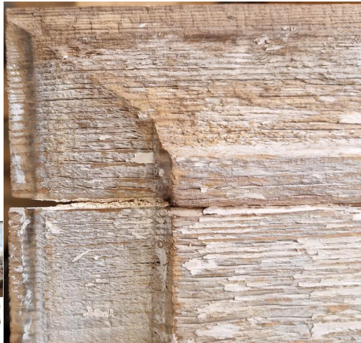
Figur 18. Fyllningen sedd framifrån. Förstorad del av hörnet där frishyveln har gått för djupt.
