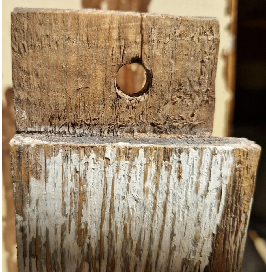
Figur 21. Mellanstyckets vänstra tapp med spår efter kap- och klyvsnitt.
