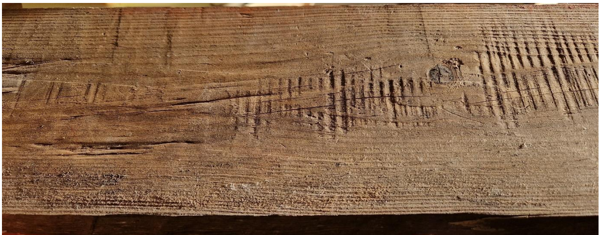
Figur 29. Baksidan av bottenstycket. Spår av ramsågning och handhyvling.
