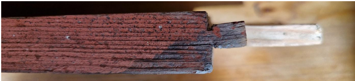
Figur 26. Vänstra sidostyckets övre ända sett från sidan. Baksidan vänder uppåt. Närmast syns den korta delen av tappen som fyller ut notspåret i krönlisten.
