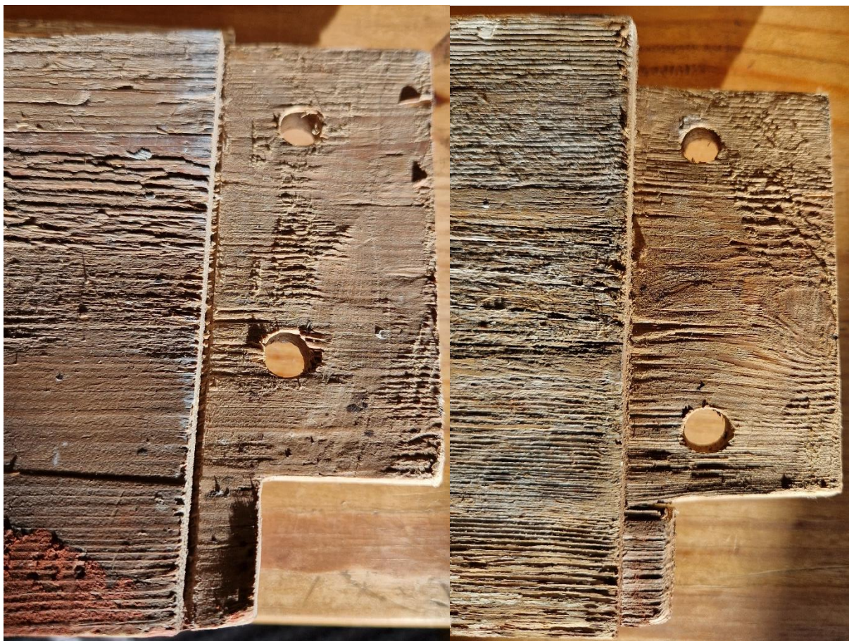
Figur 24. Bild som visar sidostyckenas tappar, med spår av kap- och klyvsnitt samt täljning.
