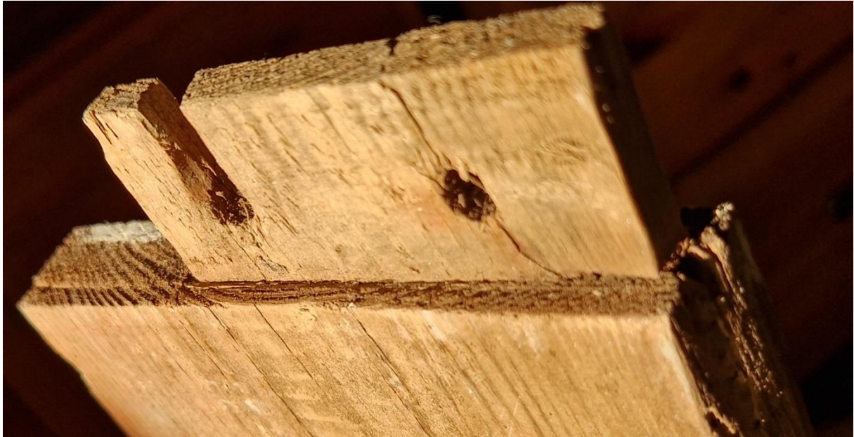
Figur 27. Baksidan av bottenstyckets högra tapp. Spår efter kap- och klyvsnitt.
