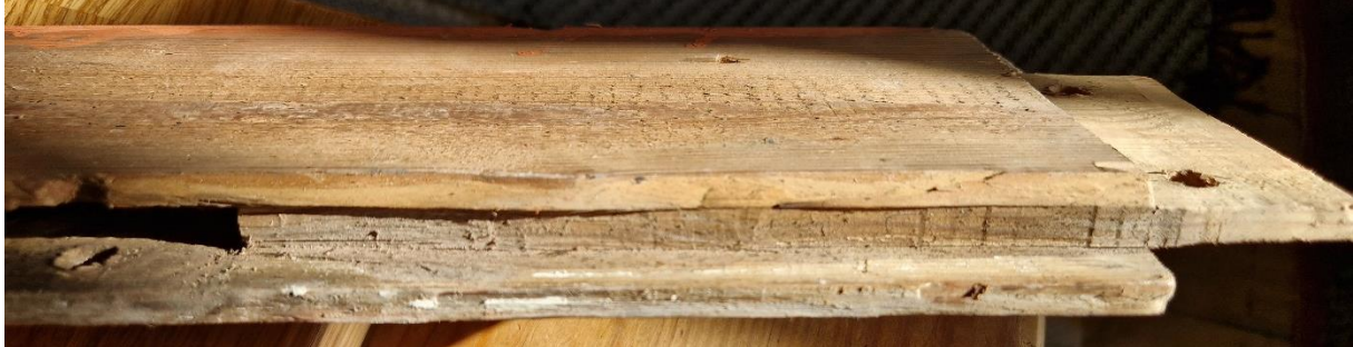
Figur 25. Högra sidostycket sett från sidan, inifrån öppningen. Tapphållet för mellanstycket till vänster och det trasiga notspåret mitt i bild. Längst till höger tappen som går in i krönlisten.
