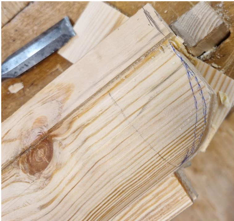
Figur 34. Nya krönlistens ändträ formades med stämjärn. Rundningen ritades på fri hand.
