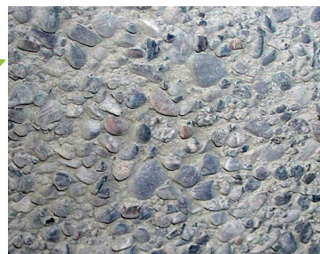
Detailansicht einer mittels CSE® Entaktivierer erzeugten Abschnittsfugenoberfläche
