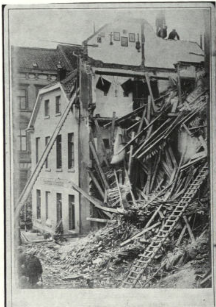
Hauseinsturz Gerberstraße 34 am 10. 8. 1890
