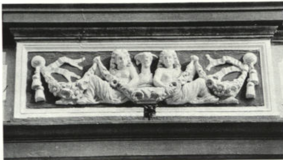
Bild 13: Luisenstraße 29: Stuck zwischen Gurtgesims und Fensterbank
