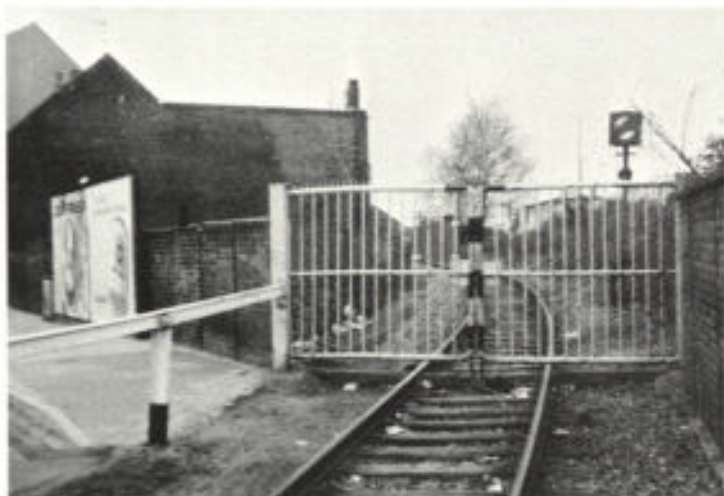
Abb. 3. Einfahrt zum Betriebsgelände an der Trift; links die ehemalige Dienstwohnung
