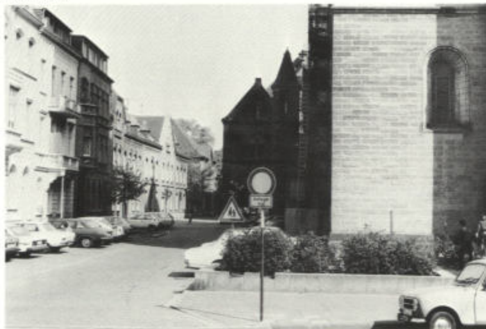
Abb. 25. Blick auf einen Teil des neuromanischen Ensembles in der Straße „An der Josefikirche“
