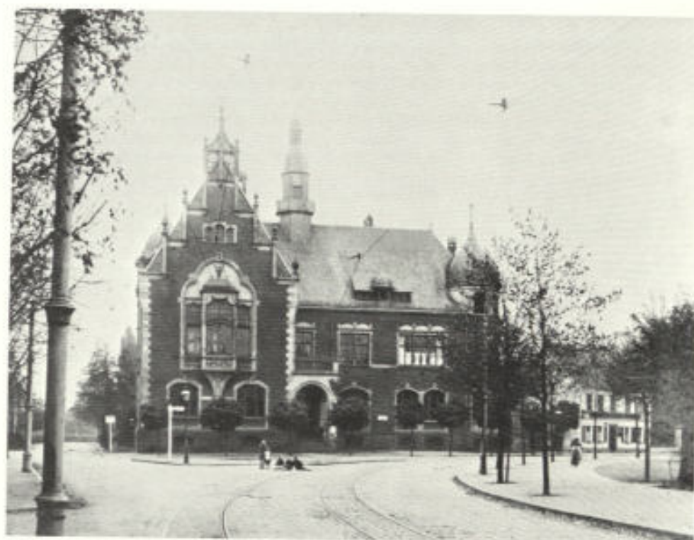
Abb. 1. Rathaus in Bockum; Architekten: Girmes und Oediger; erbaut 1902 bis 1904
