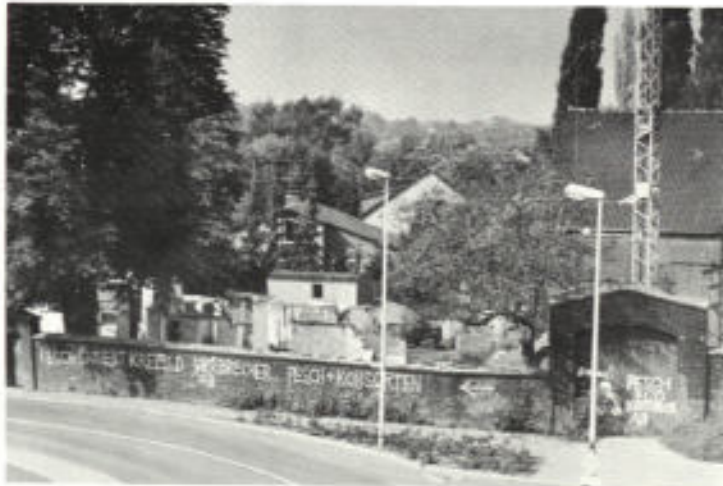
An einen Bauunternehmer verkaufte die Stadt das von Marianne Rhodius ererbte Anwesen Krefeltshof an der Buschstraße. Zu spät merkte die Stadtverwaltung, daß der Käufer das denkmal-
