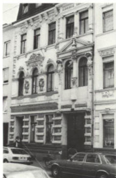
Abb. 20. Eine mit Ornamenten überladene Fassade — Jägerstraße 56
