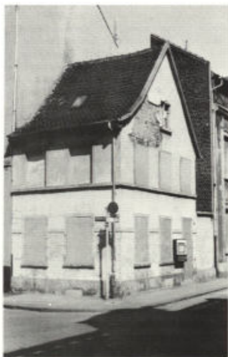
Abb. 17. Eines der ältesten Häuser Krefelds — Stephanstraße 65 — ist in Gefahr, im Sanierungsgebiet Wallstraße/B-Plan 400 zu verschwinden. Unter dem abbröckelnden Putz erkennt man die Fachwerkstruktur.
