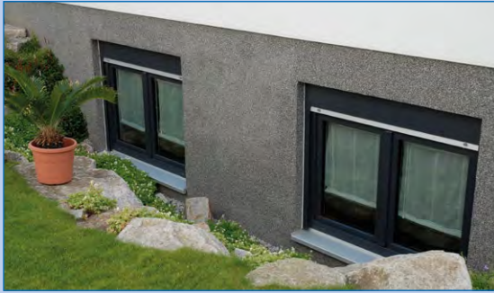
Abb. 17 Kellerfenster mit Sockel
