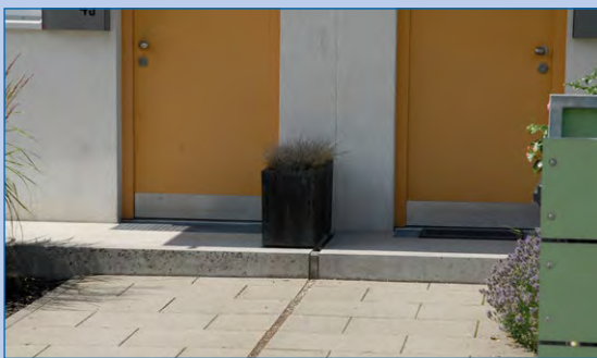
Abb. 18 Aufkantung am Gebäudezugang
