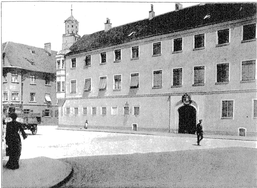
1. Augsburg: Rückgebäude des Fuggerhauses.
