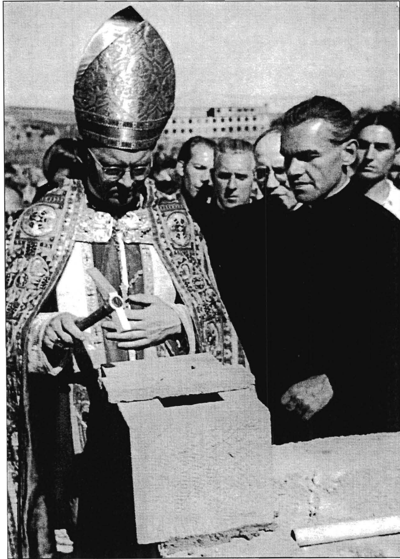
Grundsteinlegung zum Bau der Kettlersiedlung am 3. Juli 1949 durch H.H. Weihbischof Dr. Stein.
