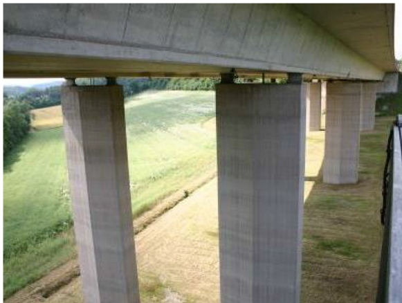
Bild 1: Talbrücke einer Bundesfernstraße
