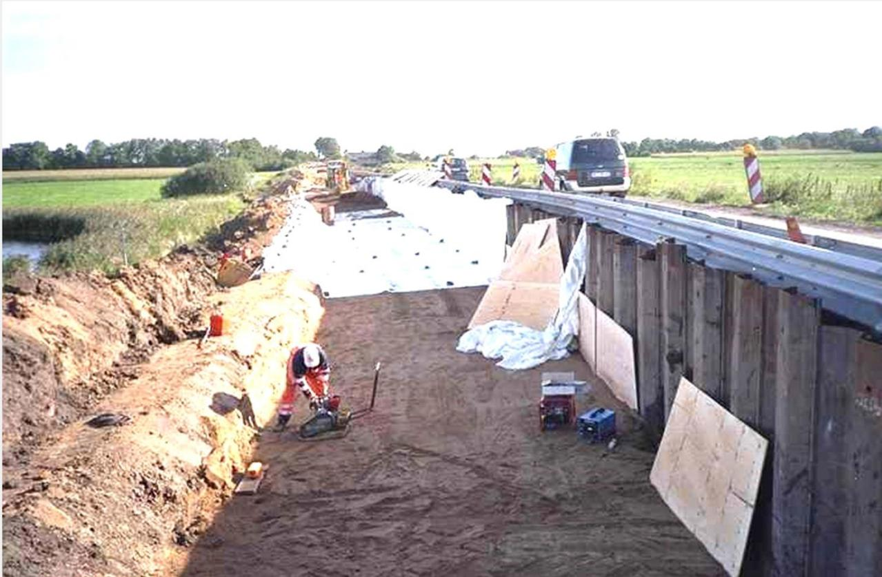
Beispiel eines Straßenquerschnittes mit Blähton-Schüttung auf wenig tragfähigem Untergrund
