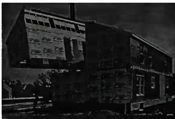
11,12 Raumzellenmontage vor Ort; "Probepassung" im Werk
