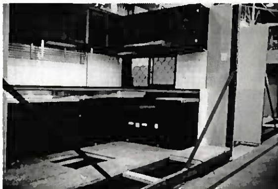
9,10 Bodenplatte, Küchenausbau, Raumzellenzusammenbau in der Fertighausfabrik
