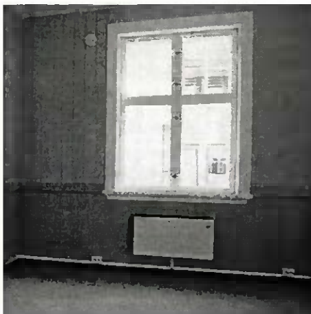
5,6 sichtbare Leitungsführung im skandinavischen Holzhaus
