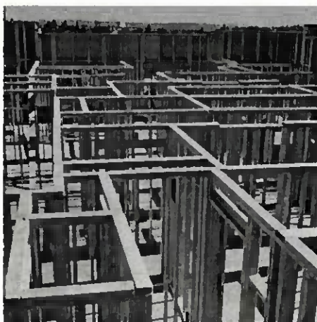
7.8 Platform framing im Bau, amerikanische Zimmerleute (framer)
