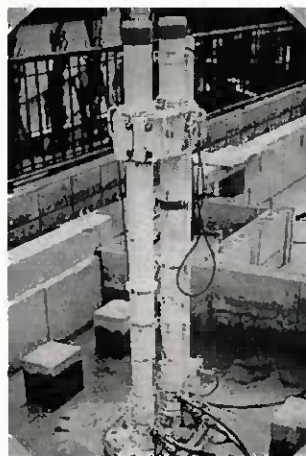
39,40 „J“ Jack up – System zum Bau von Fertighäusern ohne Gerüst und Kran; hydraulische Presse
