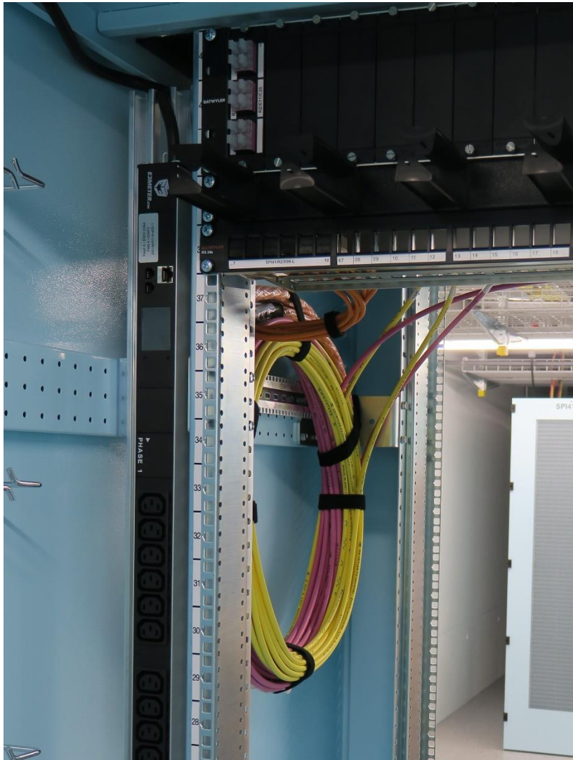
Abbildung 18 Überlängen im Rack
