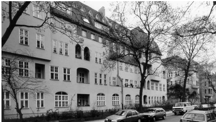
Einküchenhaus Wilhelmshöher Straße 17 & 18 & 19 & 20
