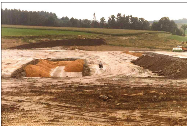
Bild 5: Herstellung von Entwässerungstreifen Figure 5: Construction of drainage stretches
