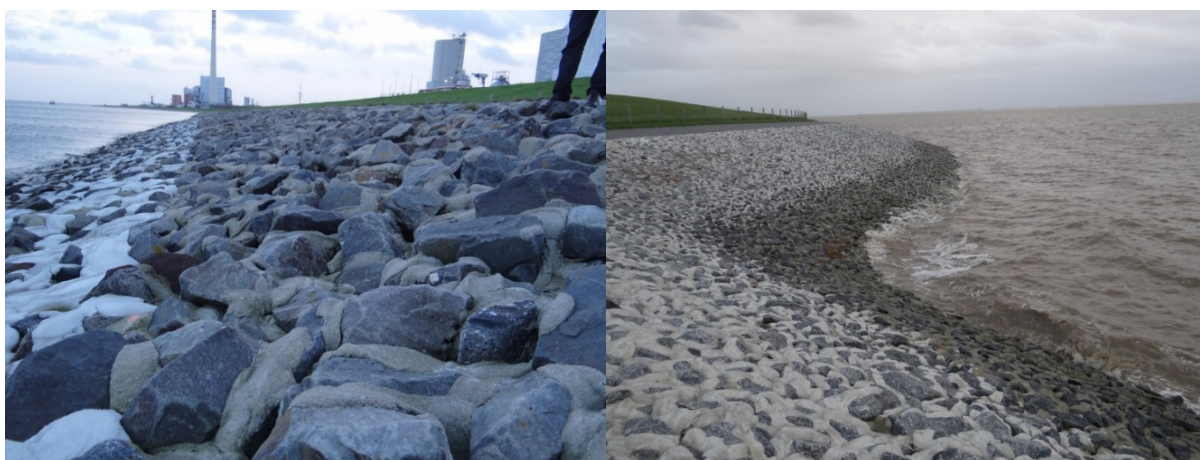
Abbildung 1: Mörtelvergossene Schüttsteindeckwerke, links teilvergossen, rechts vollvergossen (Fotos: Kreyenschulte 2015).
