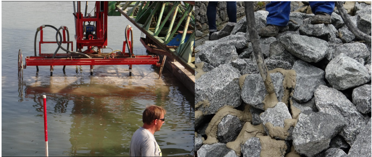
Abbildung 2: Herstellung des Mörtelvergusses 1) mit einem Verteilerwagen unter Wasser (links), 2) von Hand über Wasser (rechts) (Fotos: Kreyenschulte 2016).
