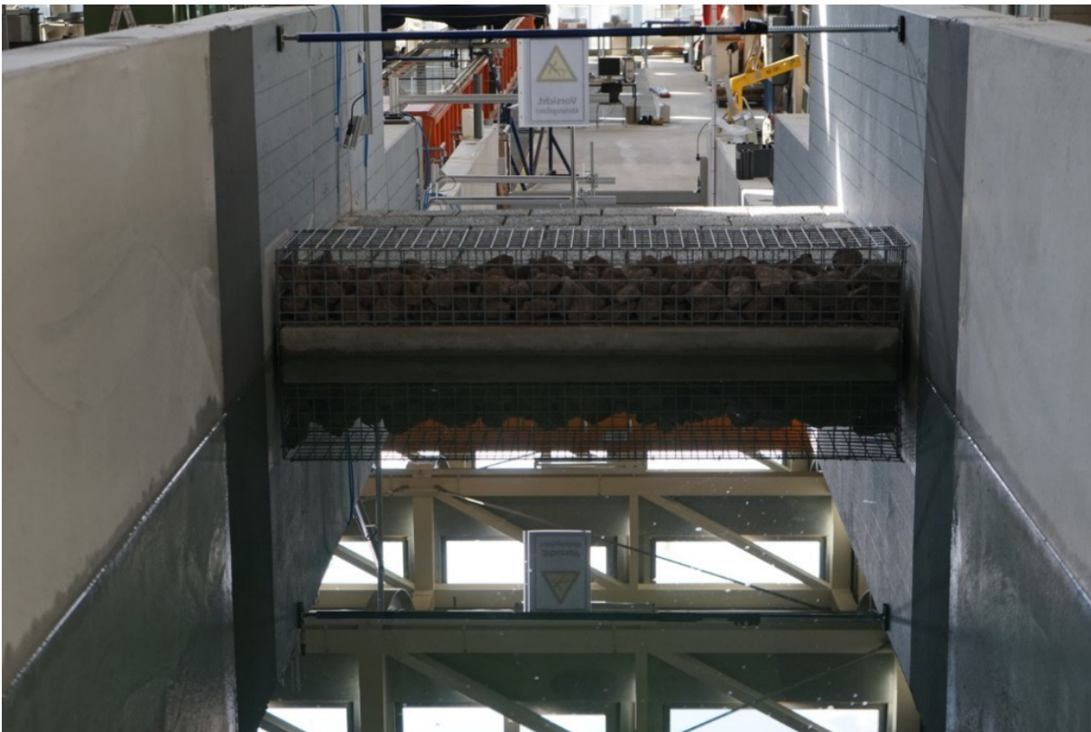
Abbildung 18: Einbau des Modelldeichs für Durchsickerungsversuche.
