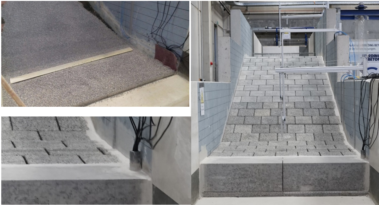
Abbildung 31: Ausführung der Verbindungskabel bei Einbau des Filtermaterials (links oben) sowie nach Einbau des Deckwerks (links unten), rechts: Aufbau des kompletten Deckwerks abgeschlossen.
