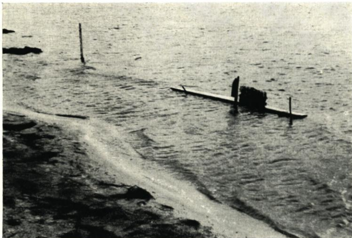
Abb. 17 Schwimmender Wellen- brecher am Versuchsfeld mit dahinter aufgebautem Strandhöft
