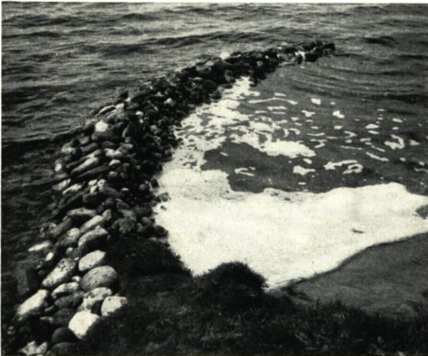
Abb. 12. Sichelbuhne im Versuchsfeld am 10. 7. 1953 unmittelbar nach dem Bau
