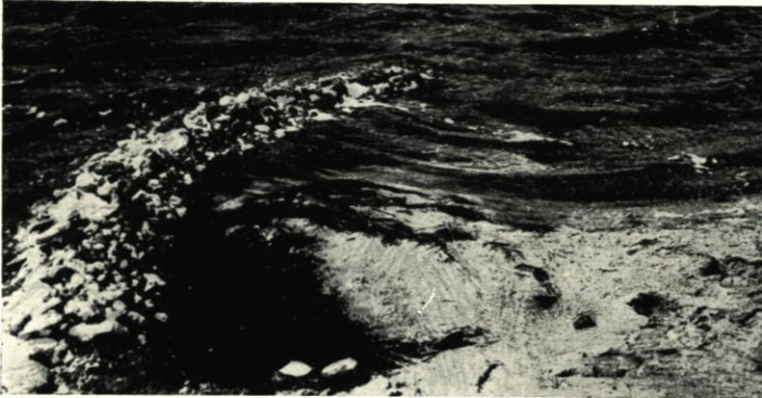
Abb. 15. Sichelbuhne am 16. 7. 1953 bei entgegengesetzter Brandungsrichtung. Diese wird im Bühnenfeld im günstigen Sinne gebeugt
