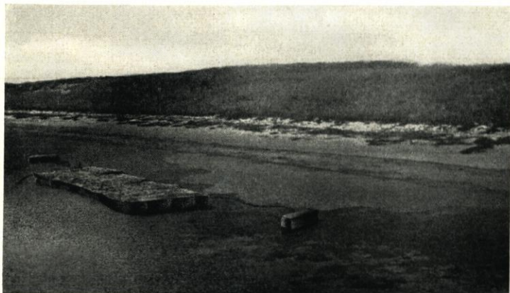
Abb. 18 Sandansammlung im Schutz eines aus Seegrass gebauten Wellenbrechers bei Niedrig- wasser aufgenommen
