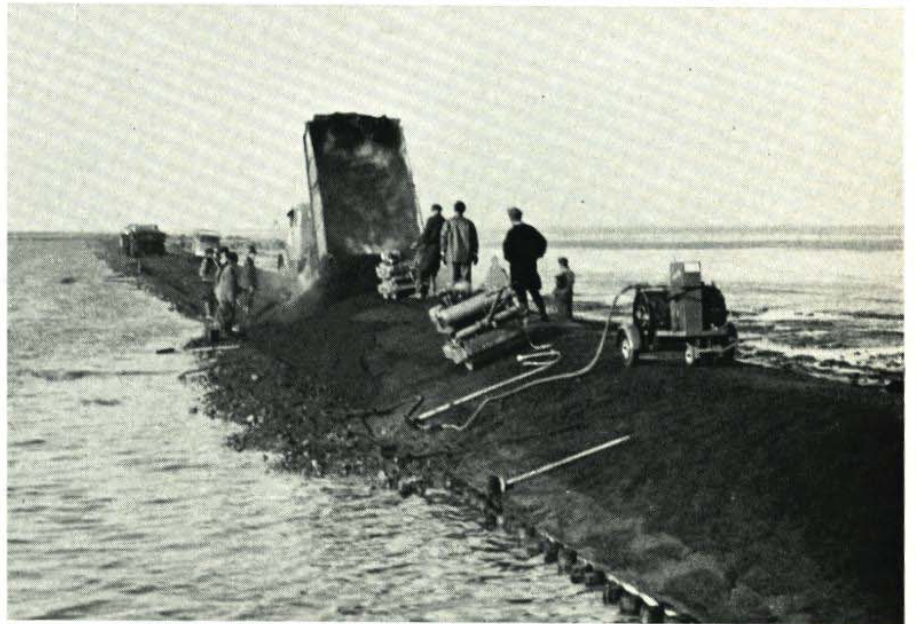
Abb. 17 Einbau der Asphalt- betonschicht (Oster- marsch)
