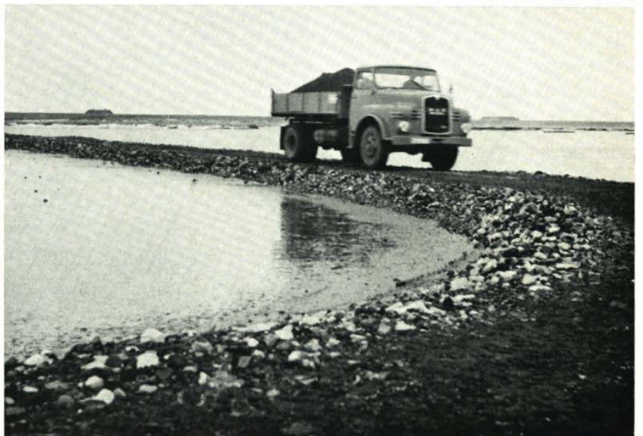
Abb. 18 Fahrspur aus Verhüt- tungsrückständen auf dem Watt bei Pilsum (s. Abb. 1)
