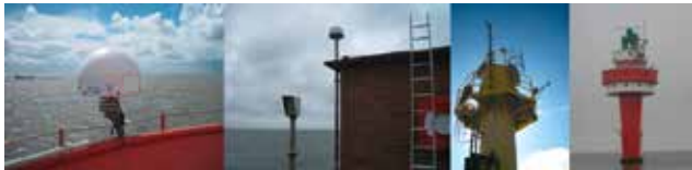
Abb. 5: GNSS-Stationen Unterfeuer Dwarsgat, Borkum-Fischerbalje, Dukegat und Leuchtturm Alte Weser
