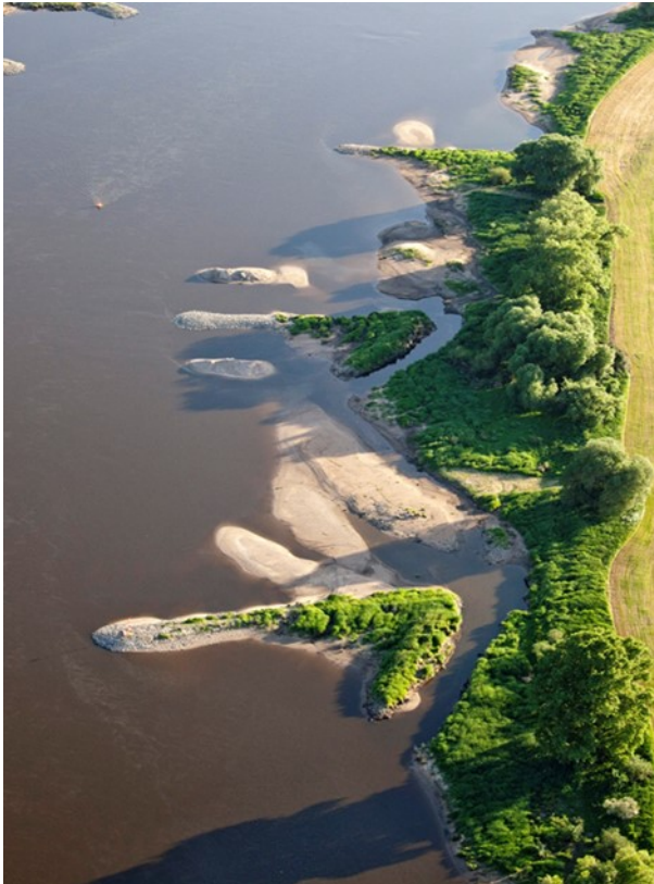
Bild 4: Beispiel instandgesetzter und wieder regelungswirksamer Buhnen an der Elbe mit Durchstich im Bereich der Buhnenwurzel (Quelle: WSA Dresden)
