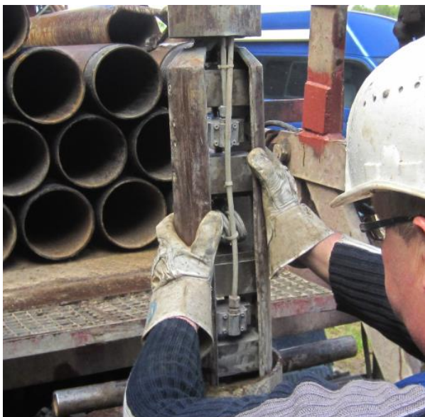
Bild 16: Seitendrucksonde auf der Baustelle
