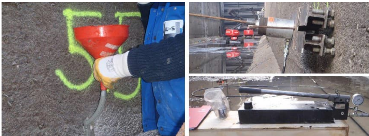
Bild 4 bis 6: Einbringen des Vergussmörtels in die Ankerlöcher, Ermittlung des Herauszieh Widerstand (Quelle: LPI)
