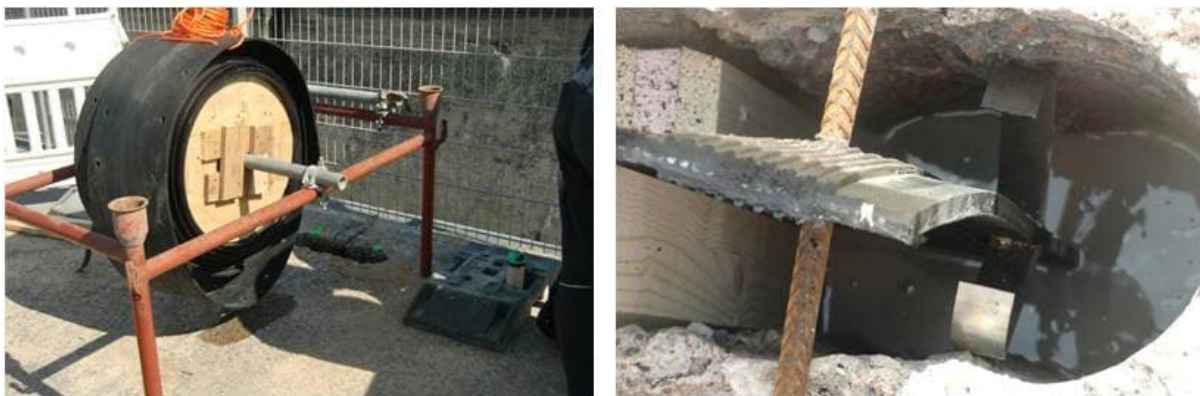
Bild 10: Einbau des SBK von der Plattform (links); Lagesicherung nach der Abwicklung im Dichtteil (Quelle: BAW)
