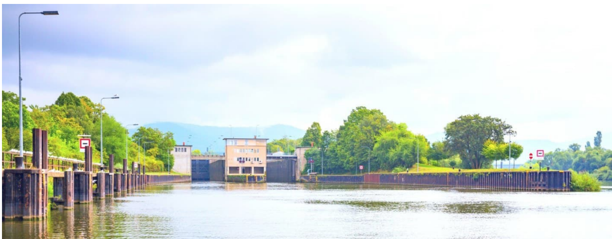
Bild 1: Unterwasseransicht Schleuse Schwabenheim (Quelle: ARGE Neckarschleusen Los 1)
