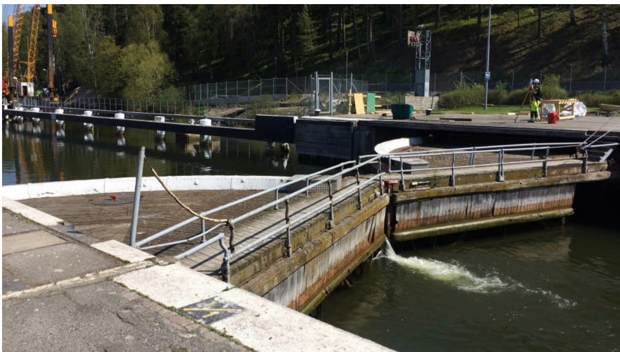
Abbildung 2: Drehtore am Oberhaupt der bestehenden Schleuse
