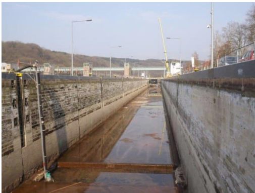
Abb. 4: Mainschleuse: Instandsetzung unter Betrieb im 14 tägigen Sperrfenster
