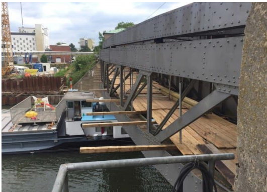
Abb. 2: Hochwassersperrtor: Instandsetzung unter Betrieb
