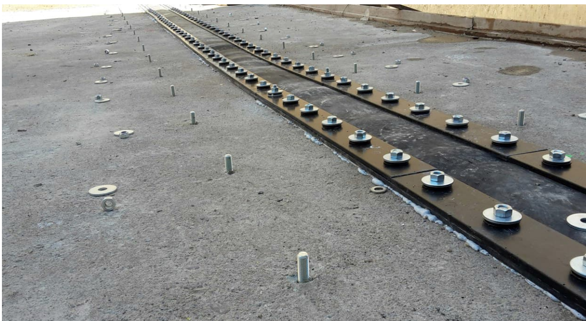
Bild 1: Auf dem Altbeton der Sohle befestigtes Klemmfugenband nachdem unter Teilbetrieb die Kammerwandfuge überbohrt wurde (Quelle: BAW)
