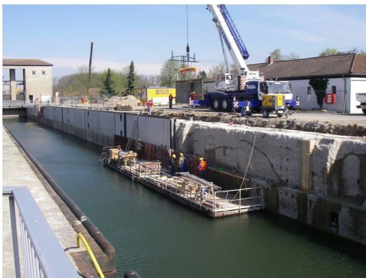
Bild 2: Instandsetzung der Kammerwände der Schleuse Wedtlenstedt mit Fertigteilen unter Betrieb (Quelle: BAW)
