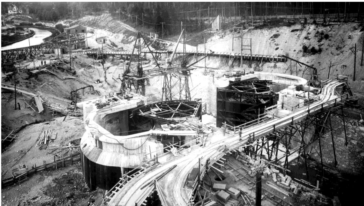
Abbildung 1: Bau der bestehenden Schleusenanlage (Quelle: Sjöfartsverket)
