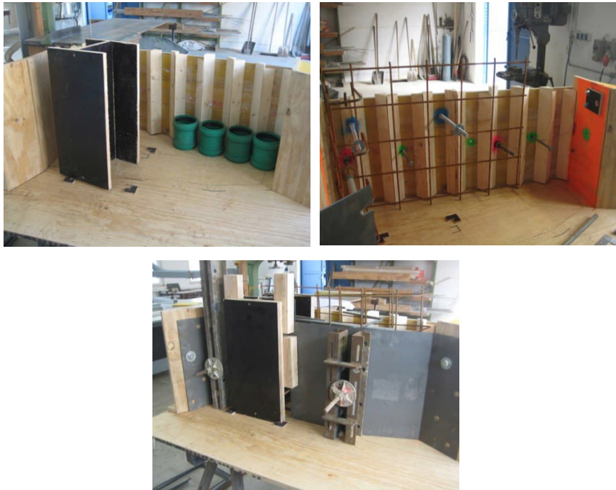
Abb. 4/5/6: Verschiedene Modellbauten der auszubrechenden Nische für den Einbau der künftigen Mauerplattenträger einschl. der notwendigen Verankerung, Bewehrung und Schalung
