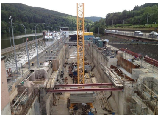
Abb. 3: Neckarschleuse: Instandsetzung unter Betrieb bei einer Doppelschleuse
