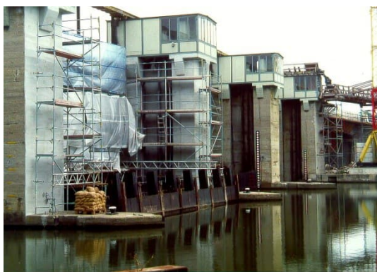
Abb. 1: Wehrbaustelle: Instandsetzung unter Betrieb im n-1-Fall
