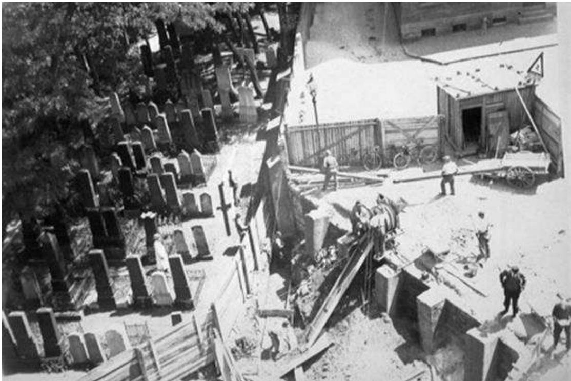
Aus einem gegenüber liegenden Haus wurden die Arbeiten heimlich fotografiert (10)
