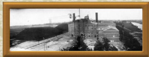
In diesem Kraftwerk wurde mit der Verbrennung von Torf Strom erzeugt.
