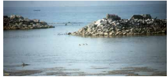
Abbildung 7: Wellenbrecher. Links: Bauprinzip, Querschnitt (Kern z. B. aus inertem Bauaushub, Deckschicht aus Wasserbausteinen, MHW, MMW, MNW – mittlere Hochwasser-, Mittelwasser-, Niedrigwasserlinie); rechts: parallel versetzte Wellenbrecher mit Durchlässen am Bregenzer Ache-Delta in den Bodensee (Aufnahme bei Niedrigwasser).
