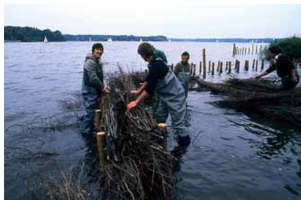
Abbildung 9: Links: Bauprinzip, Querschnitt (Doppelpfahlreihe, zuunterst die Querschicht, darüber sechs Längsfaschinen, die an den Pfählen verdrillt sind); rechts: Lahnungsbau an der Unterhavel, Berlin (Foto M. Krauß).
