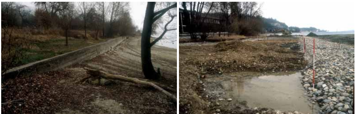
Abbildung 18: Uferrenaturierung durch Vorschüttung vor bestehende Uferbefestigungen in der Praxis. Links: Ufermauer und Vorland vor der Renaturierung; rechts: Schüttung eines einseitigen Gerölldamms und des Deckmaterials aus Kiesgrubenabraum mit breitem Korngrößenspektrum (Sipplingen, Bodensee-Überlinger See, Aufnahmen bei winterlichem Niedrigwasser).
