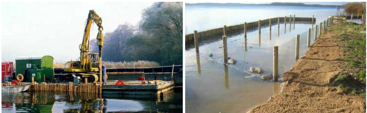
Abbildung 8: Palisaden. Links: Rammen von Palisaden am Großen Müggelsee, Berlin (Foto M. Krauß); rechts: Einrichtung einer Schilfpflanzung am Gr. Plöner See, die durch Palisaden und einen Zaun geschützt wird.
