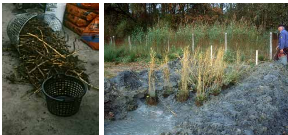
Abbildung 14: Schilf-Pflanzung. Links: Auswahl von Rhizomenstücken, die in einem Feuchtgebiet gewonnen wurden; rechts: Pflanzung von vorgezogenen Ballen (Lipbach-Mündung, Bodensee-Obersee bei herbstlichem Niedrigwasser).
