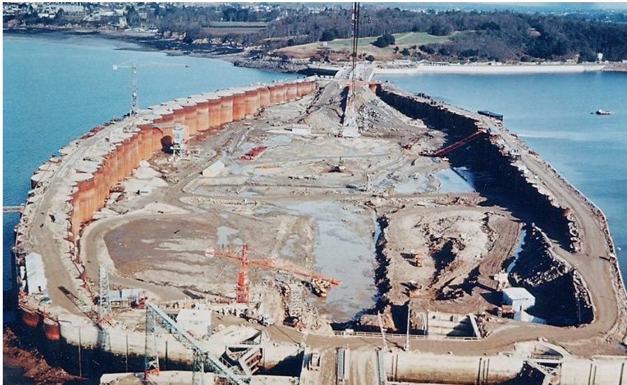
Auf der Seite in Dinard. Die 6 Tore der Staumauer hinten im Osten waren gebaut und geschlossen. Die restliche Baugrube war fast trocken. Die ersten Turmdrehkrane, 2x C. A. C. L. J. Weitz G 105 waren im Einsatz (links einer auf einem der Betonzylinder und einer vorne etwa in der Mitte in der Baugrube). Oben sieht man das Seil des Kabelkrans.
