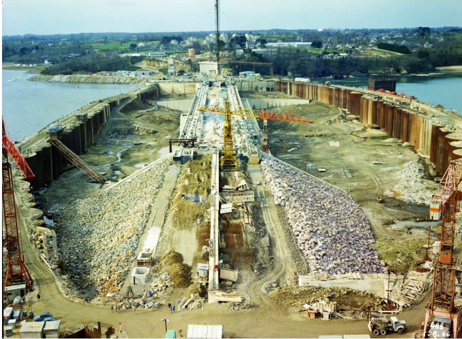
1. März 1966, das Gezeitenkraftwerk war im Rohbau bald fertig Von links nach rechts: Pignon P 200 (nur ein Teil sichtbar), C. A. C. L. J. Weitz G 105 (nur ein Teil sichtbar), Weitz G 280 HV auf der Decke des Kraftwerks
