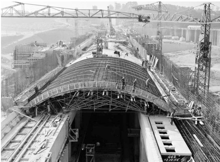
Foto 12.10.1965, das Dach der Kaverne wurde gebaut Von links nach rechts: C. A. C. L. J. Weitz G 105 (2x, 1x nur Ausleger) und Weitz G 280 HV Foto Henri Baranger
