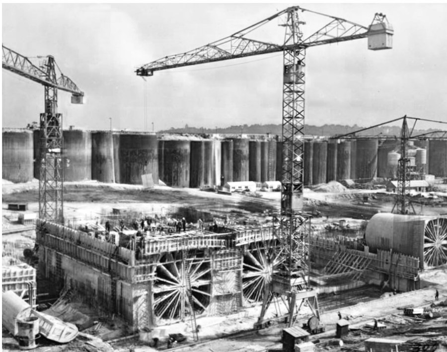
Oktober 1964, Teilansicht der Baustelle mit den Einlässen zu dem Kaplan Turbinen. Von links nach rechts: Weitz G 280 HV, C. A. C. L. J. Weitz G 105 und Pingon P 200
