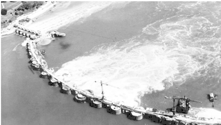
Die 6 Tore des Staudammes bei Saint-Malo waren fertig gebaut und geöffnet. Die restlichen Betonzylinder waren im Bau. Noch strömte das Wasser durch die Betonzylinder. Auf den Betonzylindern standen 2x C.A.C.L. J. Weitz G 105 und bauten an den noch fehlenden Betonzylindern weiter.
