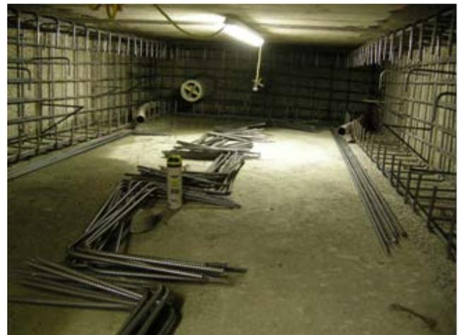
Vorbereitung Hohlkasten, Nr. 563 Nord, für Verlegen der Spannkabel und Bewehrung
