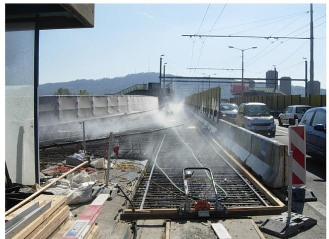
Benässung des neu zu betonierenden Überbetons einen Tag vor Ausführung Hauptbrücke Abschnitt 2
