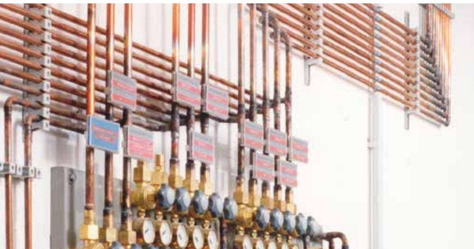
Bild 9: Rohrleitungen für Laborgase, hart gelötet (Bild Drägerwerke)
