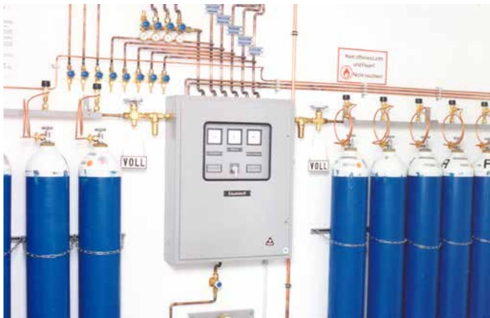
Verteilstation (Bild Drägerwerke).
