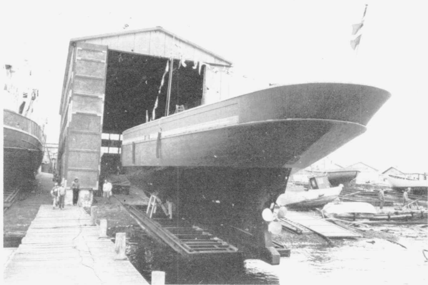
ATLANTICA på väg ut ur bygghallen vid Karstensens varv. Foto: Terje Fredh.
