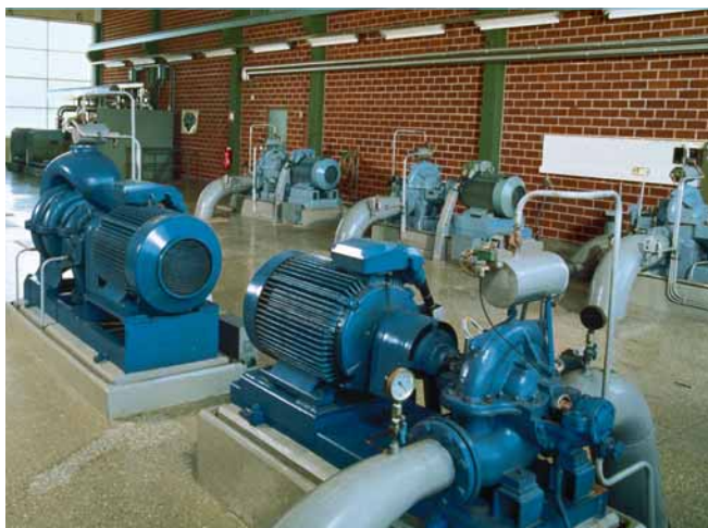
Frischwasserpumpen in einem Wasserwerk
