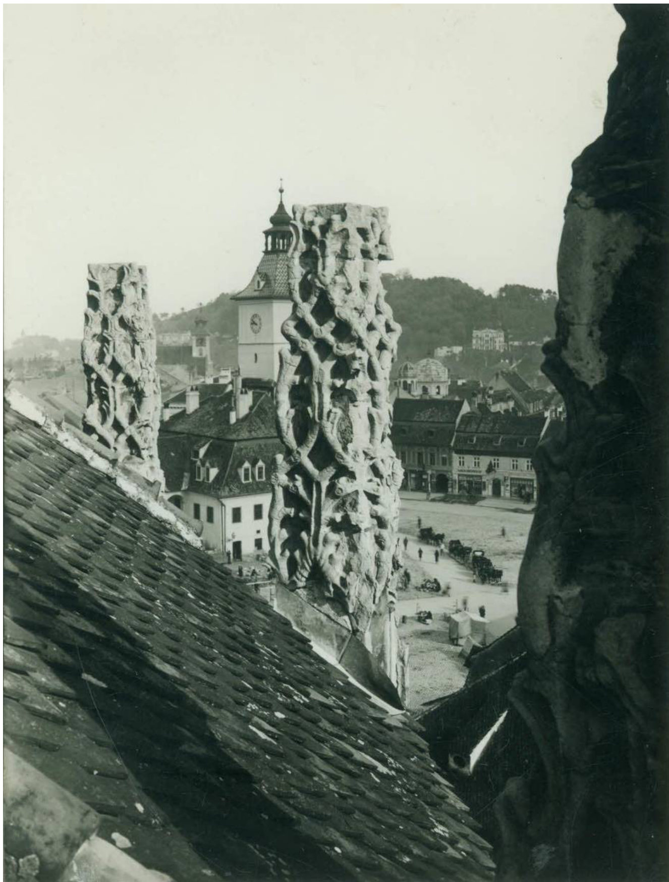
Vedere de pe partea sudică a acoperișului corului Bisericii Negre, 1936 (AN-DJAN Brașov, BV-F-00330-1-C-8-a)
