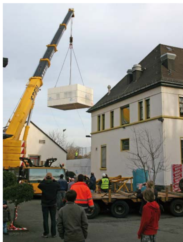
Spektakuläre Bauphase: Ein Kran hievte die Module aufs Gelände des LUA.
