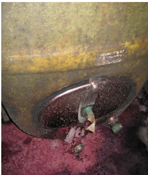
„Zentimeterdicker Schleim“: Die hygienischen Zustände in einem Weinkeller waren erschreckend.
